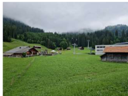
Abb. 4 Fotoaufnahme der Bauten rund um die Mittelstation Bidmi im Hinter- grund (eigene Aufnahme, 02.07.2024)
